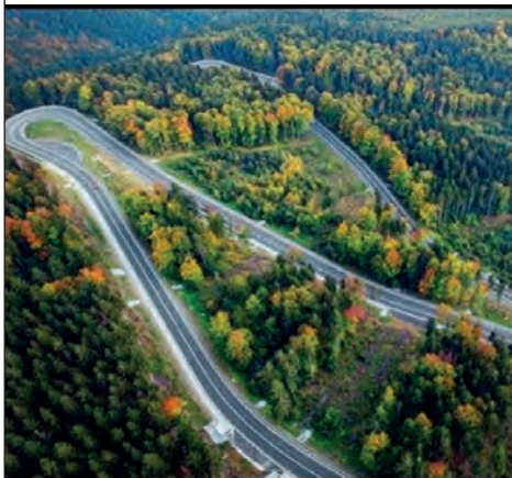
Není česká silnice jako česká silnice!!!! Nová silnice na Červenohorské sedlo
